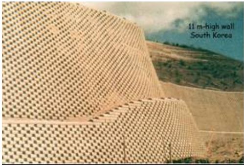
混凝土圬工挡土墙实例
