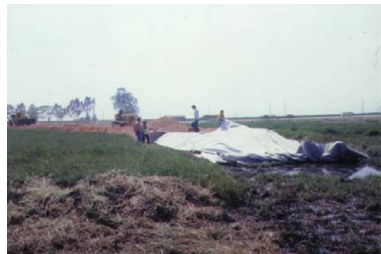
Construção de uma estrada não-pavimentada sobre argila orgânica mole
