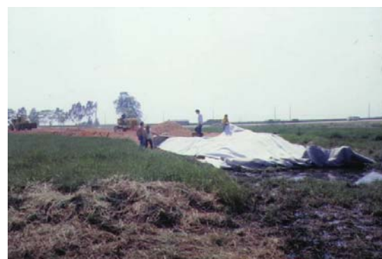
軟弱な有機質粘性土地盤上の未舗装道路の補強
