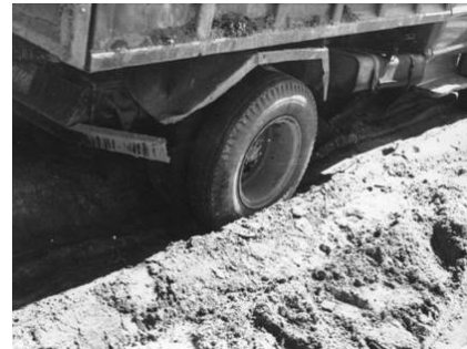
軟弱地盤における無補強の未舗装道路の典型的な劣化メカニズム
