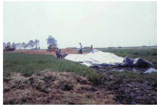
有机软粘土上未加筋铺筑的道路建造
