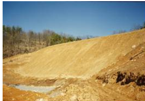
Terraplén reforzado terminado
