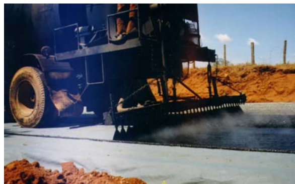
ジオシンセティックスを用いた舗装工事 (*)
