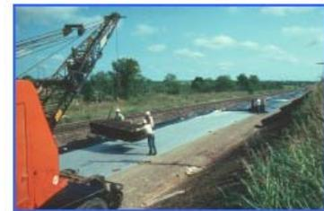
**濾過：**支持層から路盤への上向きの水の流れにより、支持層の細粒土が路盤内に侵入します。これによって、列車通過によって生じる支持層への作用応力が増加します。このような場合、ジオテキスタイルをフィルター材として機能させ、支持層からの細粒土の移動を防ぎ、間隙水の移動のみを許すという対策が有効です。このような効果を得るためには、ジオシンセティックスが、十分な透水性と強度を有する必要があります。
