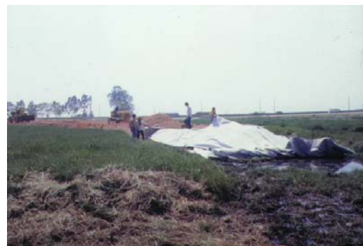
Costruzione di una strada non pavimentata rinforzata su argilla organica
