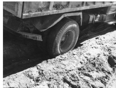
Tipici meccanismi di degradazione in strade non pavimentate su terreni molli
