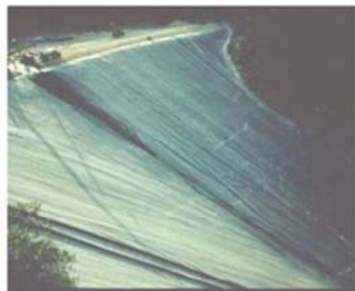
図-2 ジオメンブレンが敷かれたダム (*)
