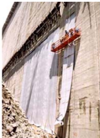
図-3 ダムの上流部分の表面への設置 (*)
