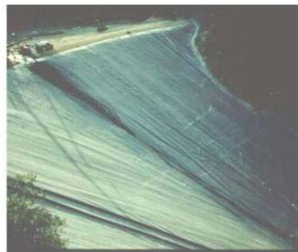
Presas revestida com geomembrana**
