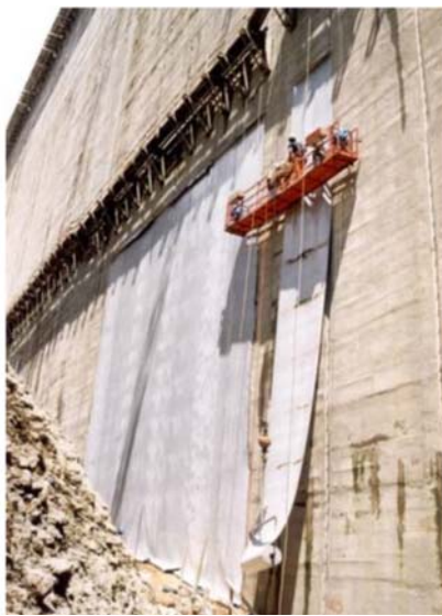
Revestimiento del talud aguas arriba de una presa (**)
