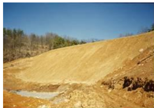
Выполненная армогрунтовая насыпь
