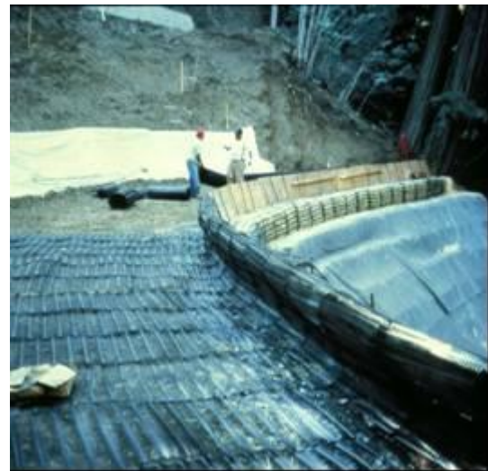
Пример армированной конструкции при ремонте откоса
