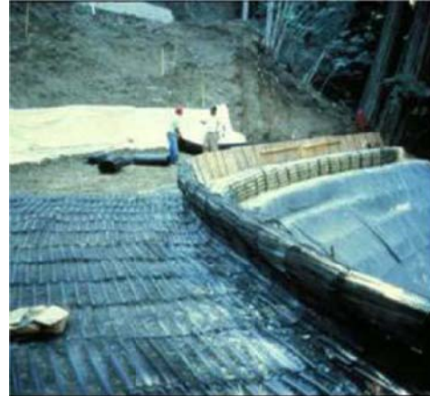
Exemplu de taluz remediat prin armare
