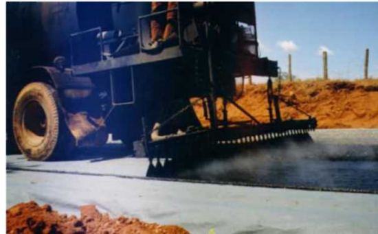
Utilizare geosintetice la pavarea drumurilor (*)
