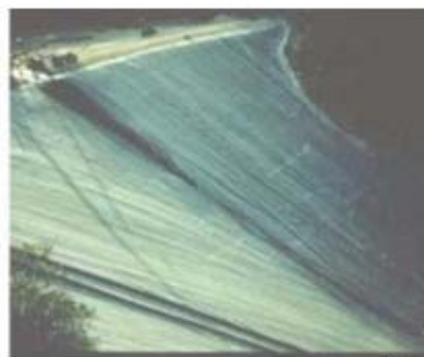
Baraj etanșat cu geomembrană
