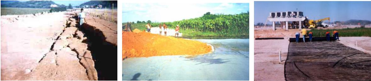
Типичное разрушение неармированной насыпи армирование геосинтетиками
