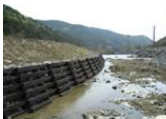
Construcción con bloques de polietileno (PE)
